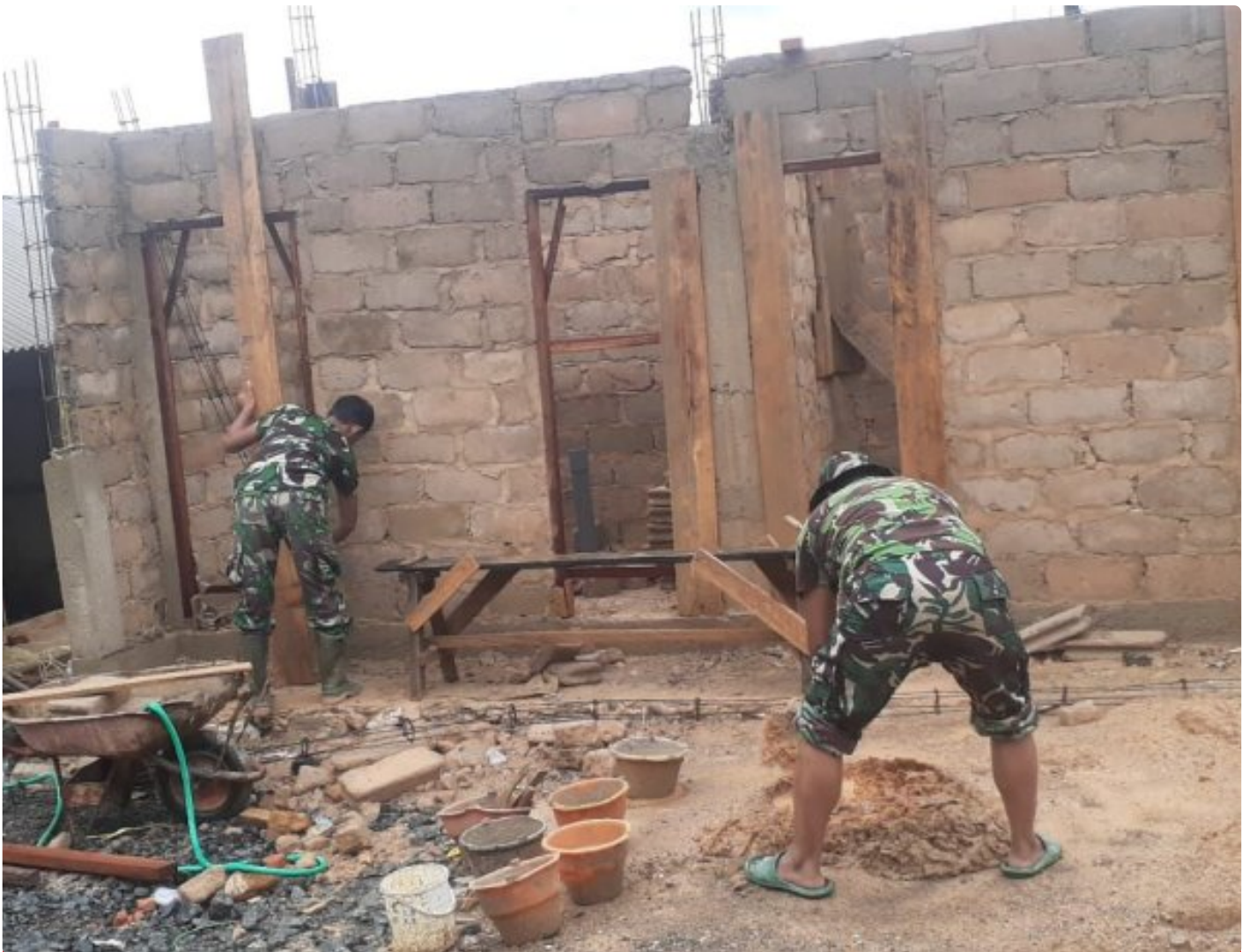
Satgas TMMD Ke 116 Kodim 1004 Kotabaru Genjot Pembangunan Tempat Wudhu Di Musholla
