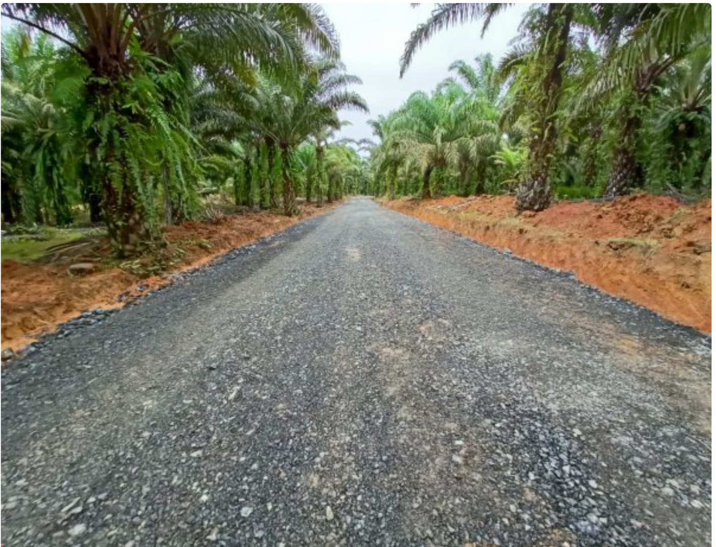
Sasaran TMMD Ke 116 Kodim 1004/Kotabaru Rampung 100 Persen
